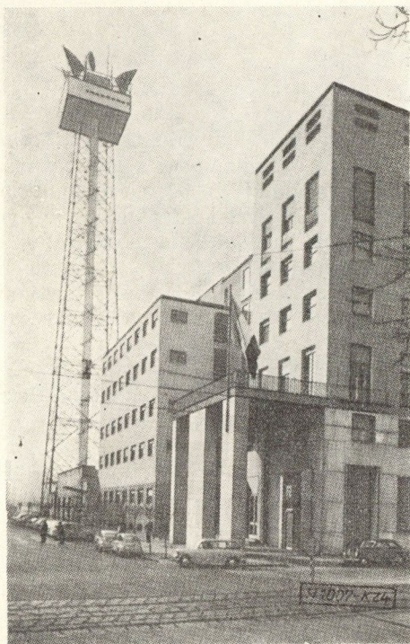
4. ábra. Tv stúdió, mellette az automatikus üzemű IV sávú tv-adót és mikrohullámú berendezéseket tartalmazó antennatorony. A torony közepén lift van. A berendezések távvezérlése a stúdióból történik
