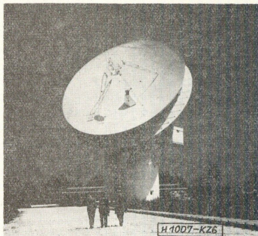
6. ábra. A fucinói földi szatellit hírközlő állomás antennarendszere
